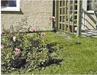
Figur 7-Eksempel på takvann ført til terreng
