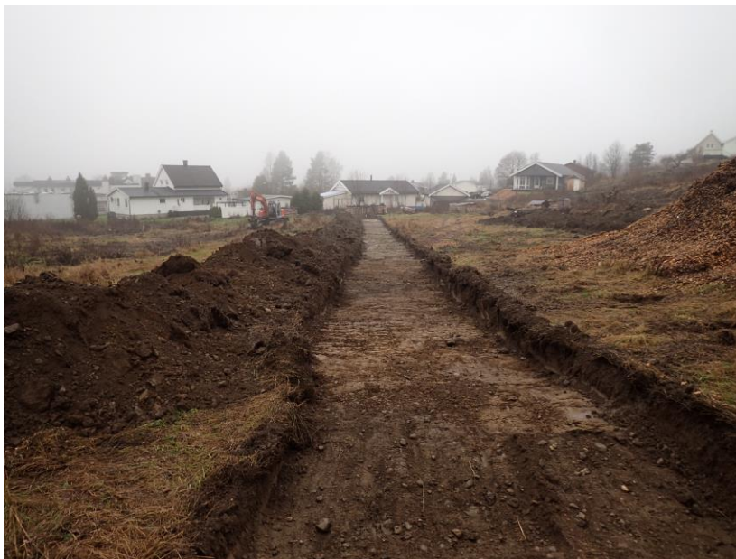
Foto 2: Bildet viser sjakt som ble gravd, sett mot nordvest.
